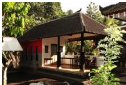
Nieuwe, gecombineerde computer lokaal en open aula Samsaman.
